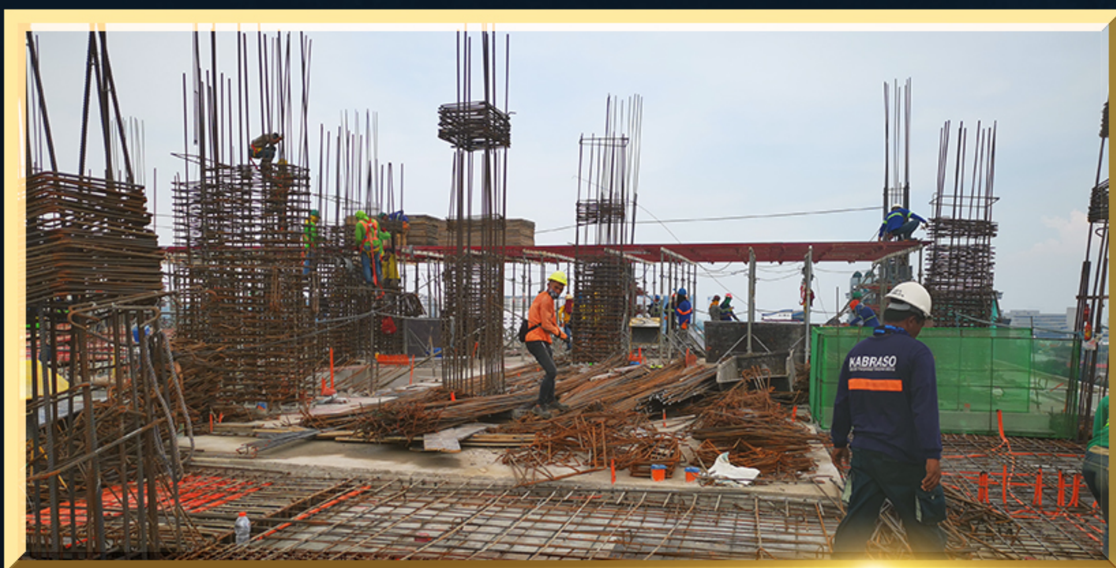
Rebar Works for Columns (17th Floor) 第17樓柱子鋼筋安裝
