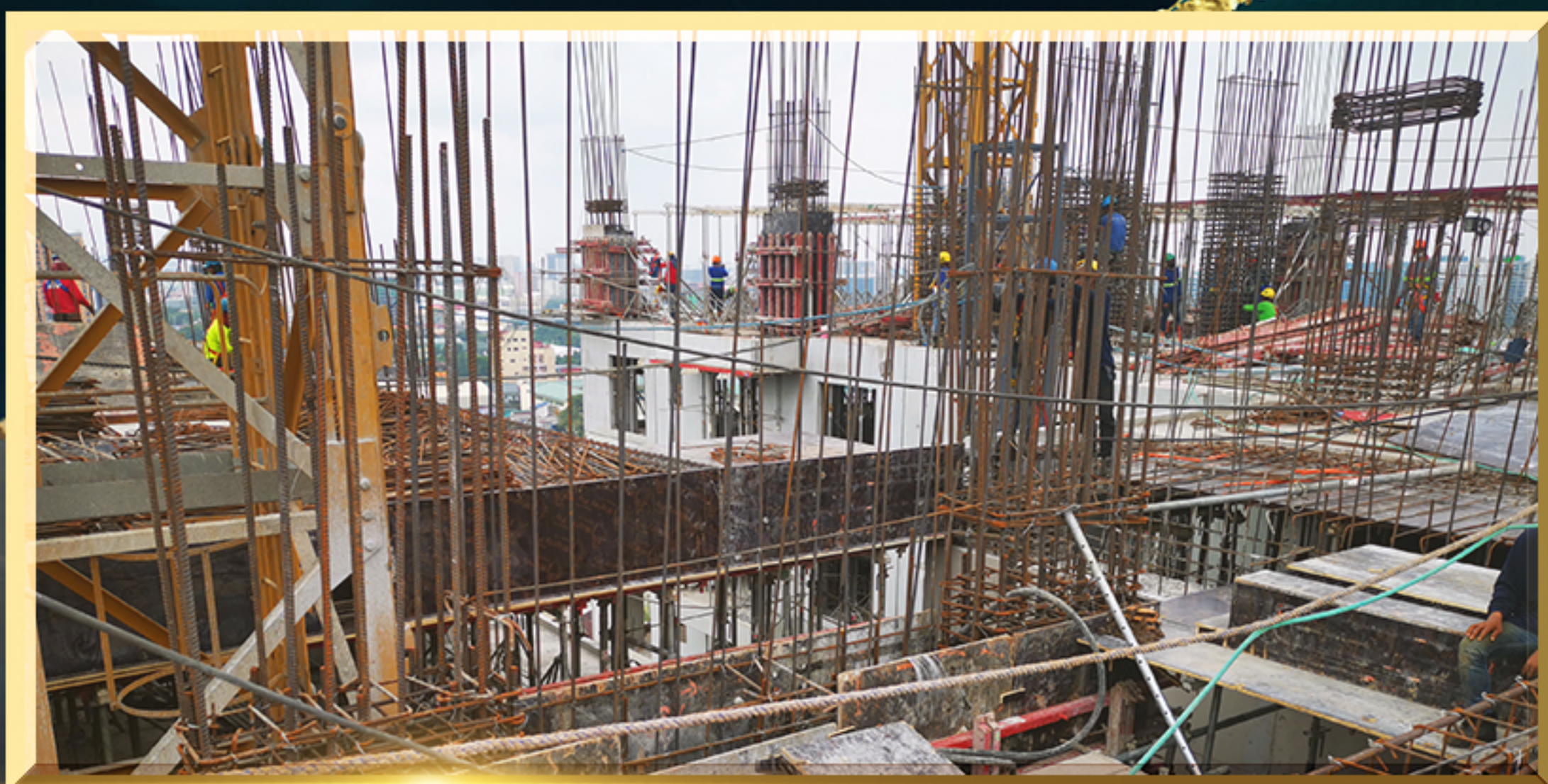
Rebar Works for Columns (17th Floor) 第17樓柱子鋼筋安裝
