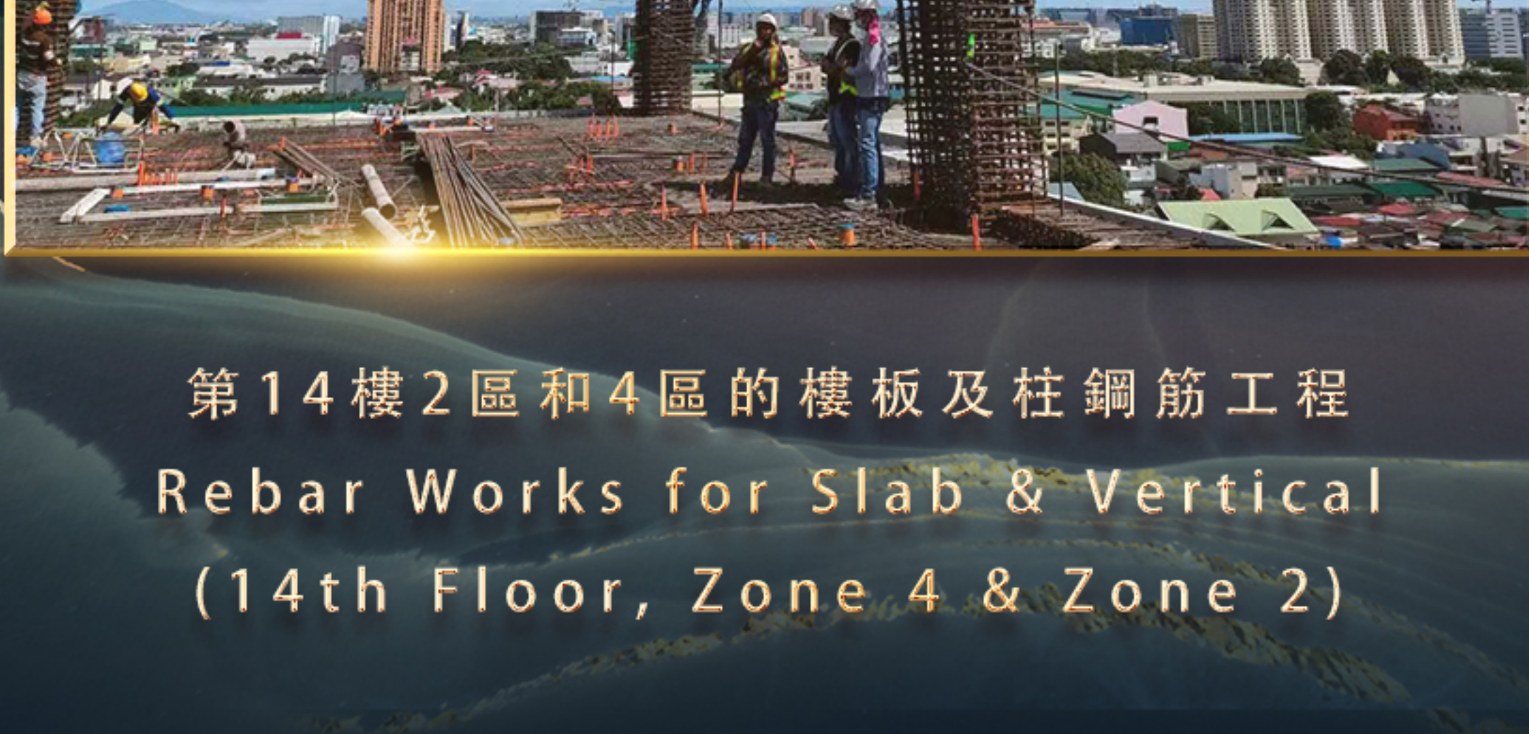
第14樓2區和4區的樓板及柱鋼筋工程 Rebar Works for Slab & Vertical (14th Floor, Zone 4 & Zone 2)
