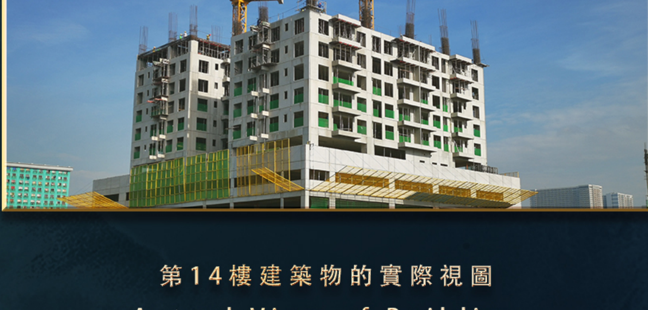
第14樓建築物的實際視圖 Actual View of Building (14th Floor)
