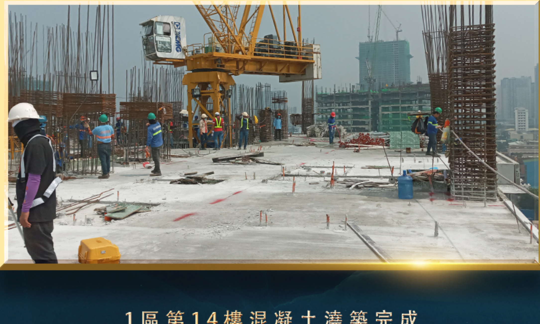
1區第14樓混凝土澆築完成 Complete Concrete Pouring (14th Floor, Zone 1)
