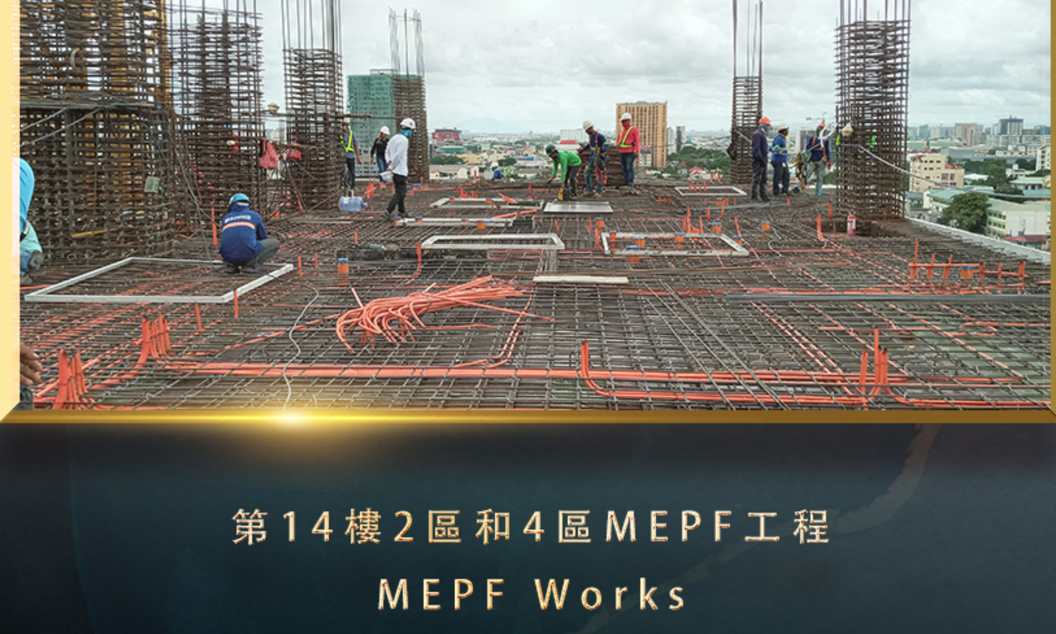
第14樓2區和4區MEPF工程 MEPF Works (14th Floor, Zone 2 & Zone 4)
